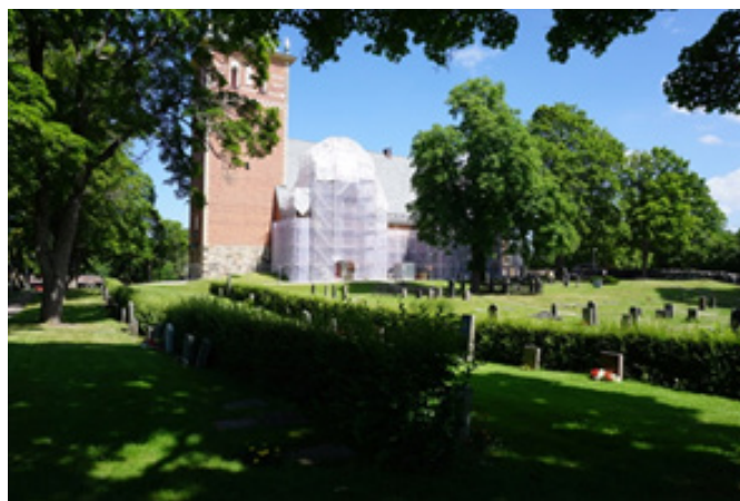
Jäders kyrka, den södra fasaden under restaurering sommaren 2021. Foto Gunhild Eriksdotter.
